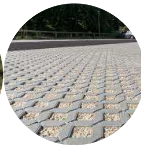
Dalle alvéolaire béton
