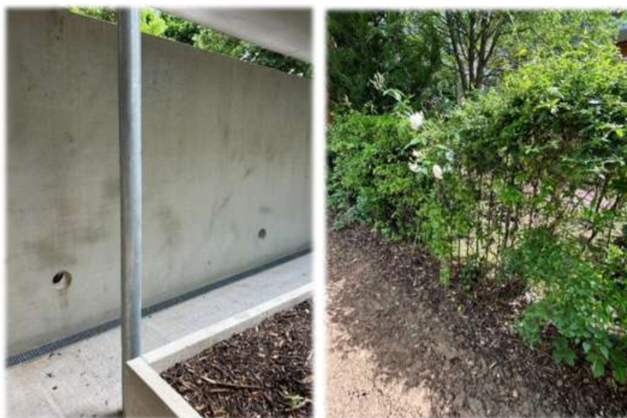
Clôture avec passages à chats (à gauche) et clôture à grosses mailles (à droite) : projet de logements collectifs , MONTREUIL (93)
