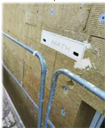
Exemple d'un nichoir en béton de bois pour martinet dans l'ITE
